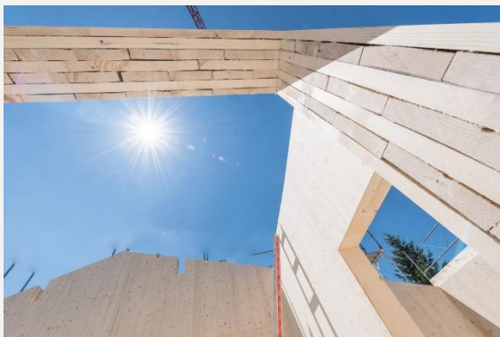
Wandelement wird aufgerichtet
