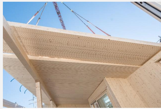
Deckenelement wird vor Ort montiert
